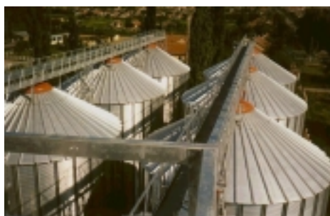
Рис.2.40. Силосные корпуса из оцинкованной стали
