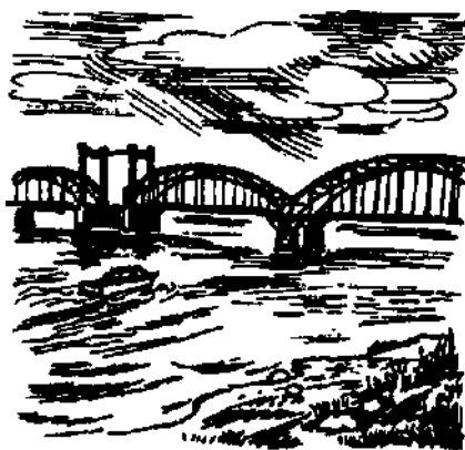
Финляндский железнодорожный мост
