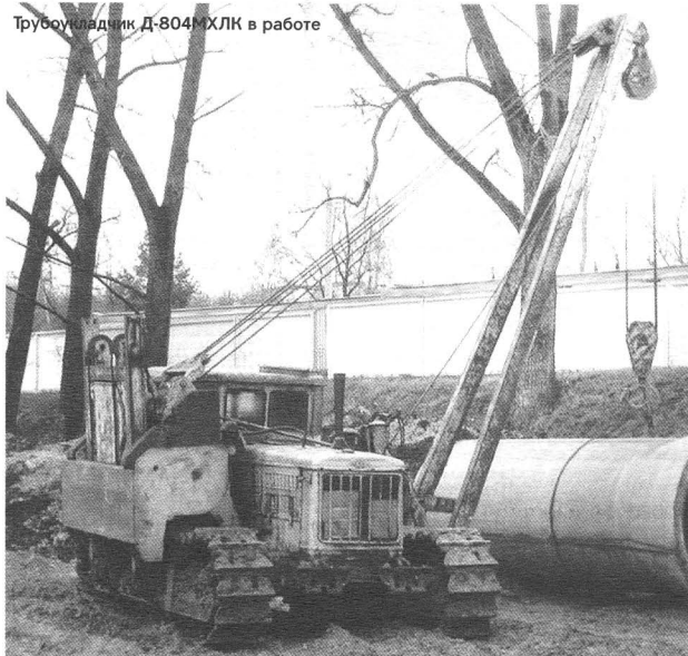
Трубоукладчик Д-804МХЛК в работе
