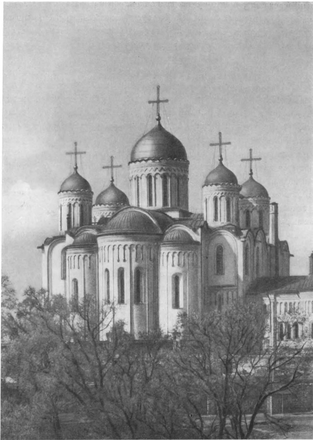
Общий вид Успенского собора во Владимире (с северо-востока). 1185 — 1189 годы.
