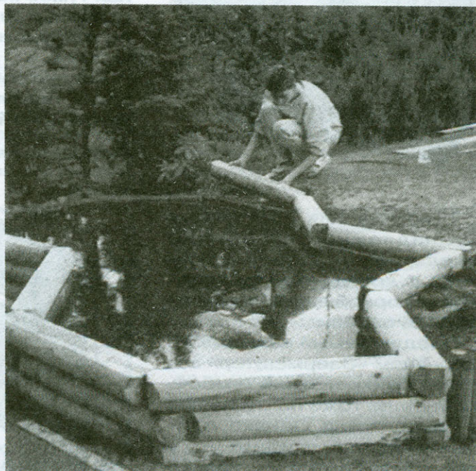
Укладка последнего ряда бревен, дополнительно прижимающего пленку.
