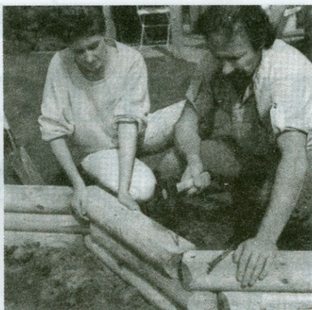
Сооружение бревенчатой стенки бассейна.
