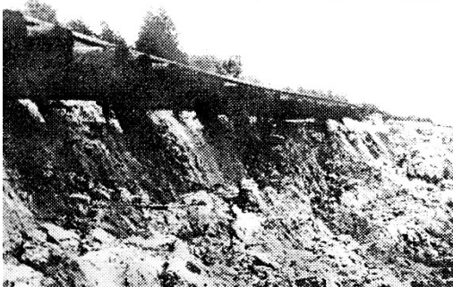
◀Рис.В.6. Одностороннее зависание путевой решетки при оттаивании насыпи из переувлажненных глинистых грунтов из-за отсутствия водоотводов на первом этапе сооружения земляного полотна железной дороги Тюмень-Сургут (428-й км, фото 1972 г.)
