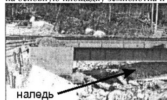
◀Рис.П.13.5. Малый мост через ручей Наледный на обходе (уклоном 40 %) Северо-Муйского тоннеля БАМа, см. рис.П.12.4 (на фото видна наледь, заполнившая почти полностью отверстие малого моста); рис. из /3/
