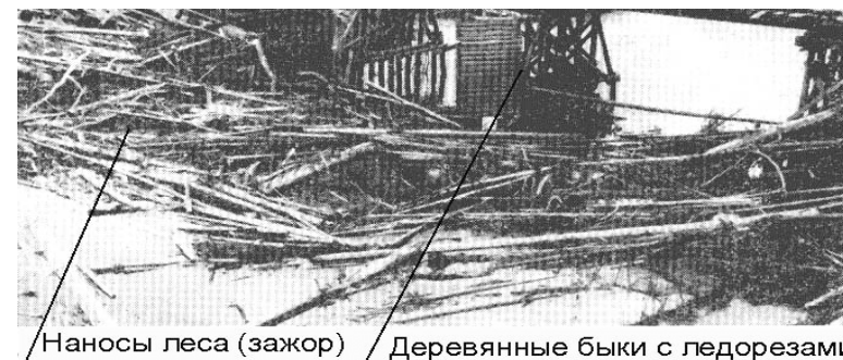
▲ Рис. В.8. Наносы леса (зажор) у моста через р.Большая Кеть на ж.-д. линии Ачинск – Абалаково во время весеннего половодья
