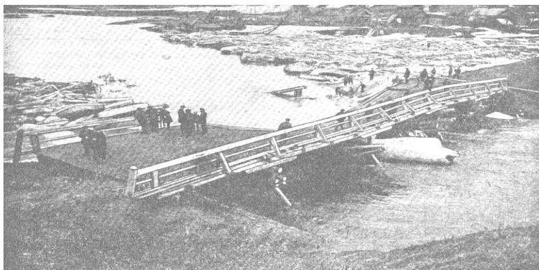
▲ Рис. В.7. Разрушение ледоходом автодорожного моста на р.Таху
