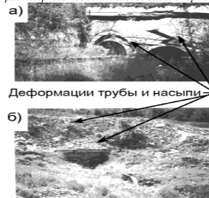
◀Рис.П.13.28. Деформации двухочковой круглой железобетонной трубы в результате неравномерных тектонических поднятий, приведших к разрушению звеньев трубы и деформации насыпи над трубой; на фото видны ремонтные гильзы, установленные в отверстия трубы для пропуска воды; а – вид с входного оголовка; б – вид с выходного оголовка; (ВСЖД, фото Н.М.Быковой, 1996 г.); рис. из /56/
