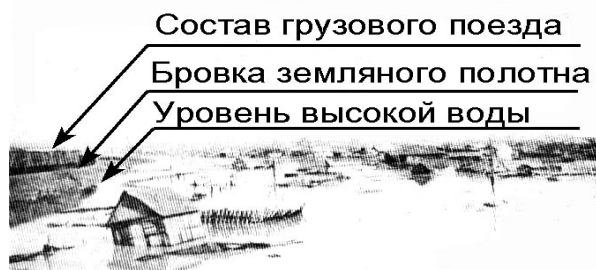
◀Рис.П.10.1. Подтопление станционного поселка и насыпи железной дороги Новокузнецк – Абакан в результате наводнения, вызванного паводком вероятностью превышения 1% (1:100)
