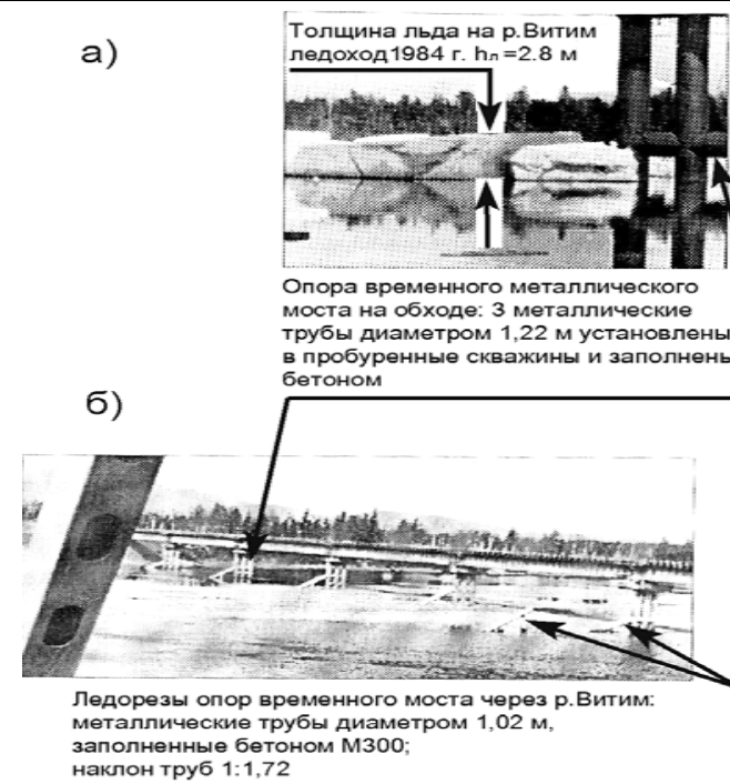
▲ Рис.В.9. Временный мост на обходе постоянного моста через р.Витим, 809-й км БАМа, участок Нижнеангарск – Чара: а – ледоход на р.Витим в 1984 г.; б – общий вид моста (сфотографировано с постоянного моста, сданного в эксплуатацию в 1989г.)
