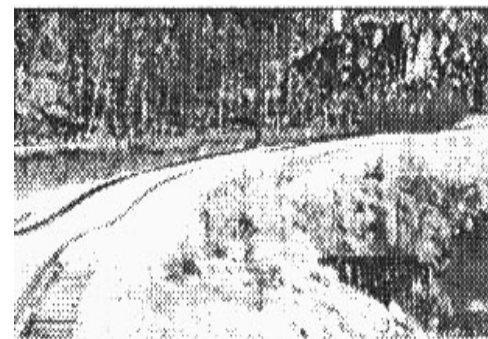
◀Рис.В.2. Просадки земляного полотна на участке пересечения обходом оз.Окунево у раз.Кодар; на переднем плане видно водопропускное сооружение – МГТ отв. 2 \times 1,5 \text{ м}
