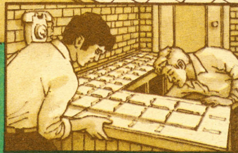
Проставки между плитками (для декоративного шва) и окантовка планкой.
