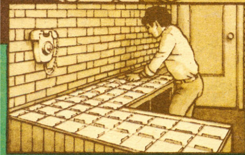
Проставки между плитками (для декоративного шва) и окантовка планкой.
