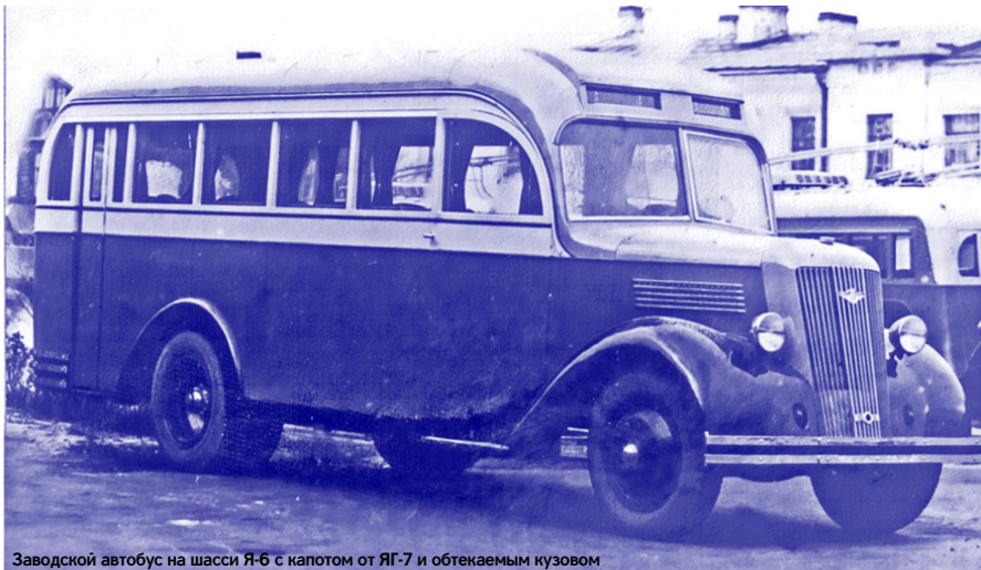
Заводской автобус на шасси Я-6 с капотом от ЯГ-7 и обтекаемым кузовом (иногда ошибочно называемый ЯГ-7А), Ярославль, 1939 г.
