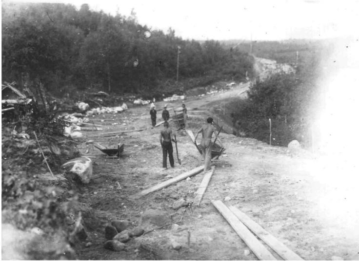
Строительство шоссе в д. Крошнозеро Пряжинского района. 1932 г. Фото А. Анкудинова. НА РК
