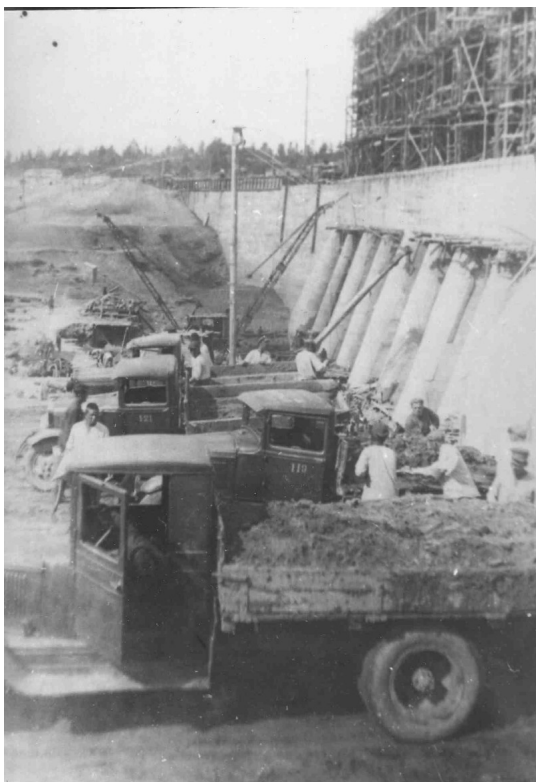
Строительство Туломской ГЭС. 1936 г. НА РК
