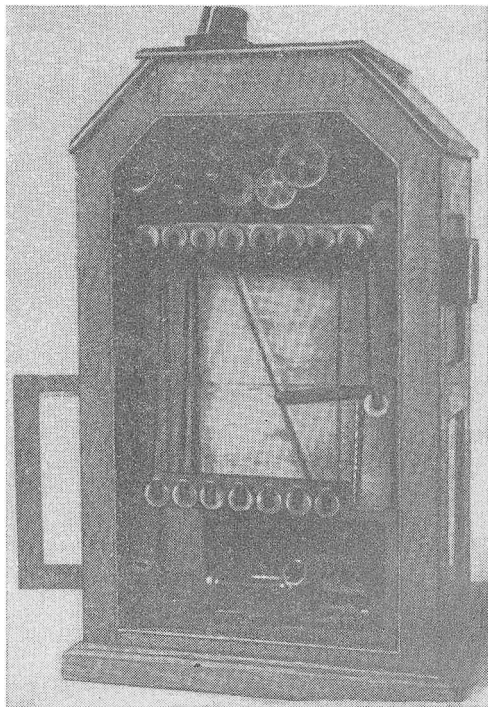
Кинетоскоп Эдисона—Диксона. Зрительное отверстие наверху
