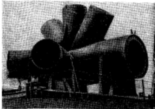
Рис. 2.18. Узел соединения раскосов
