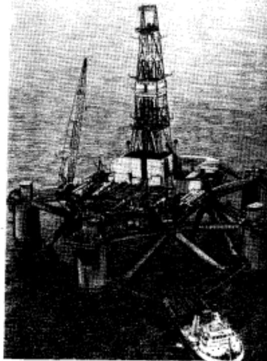
Рис. 1.16. ЦПБУ № 3000 в виде монолитного стального блока
