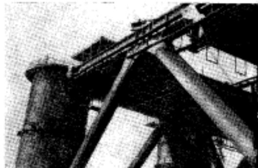
Рис. 2.21. Монтаж верхнего каркаса из подпалубных балок
