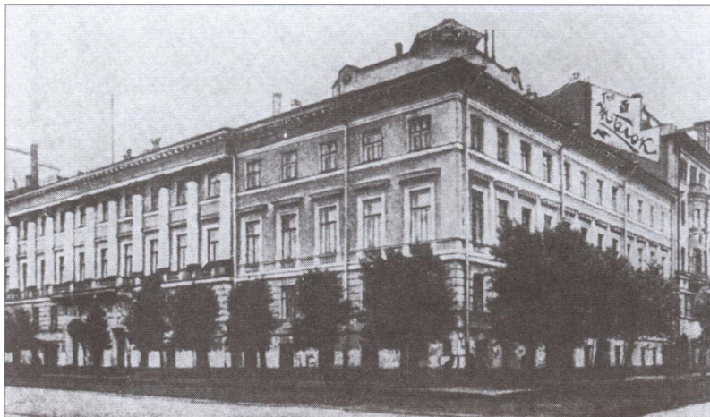
Петроград (Петербург), Гороховая ул., 2. Здесь с декабря 1917 г. до переезда в Москву находилась ВЧК, с 10 марта 1918 г. — Петроградская ЧК
