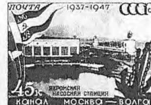
1318. Яхромская насосная станция
