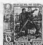
2813. Нивелировка строительной площадки
