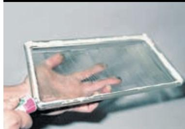
Наносим на край стекла герметик равномерным валиком.
