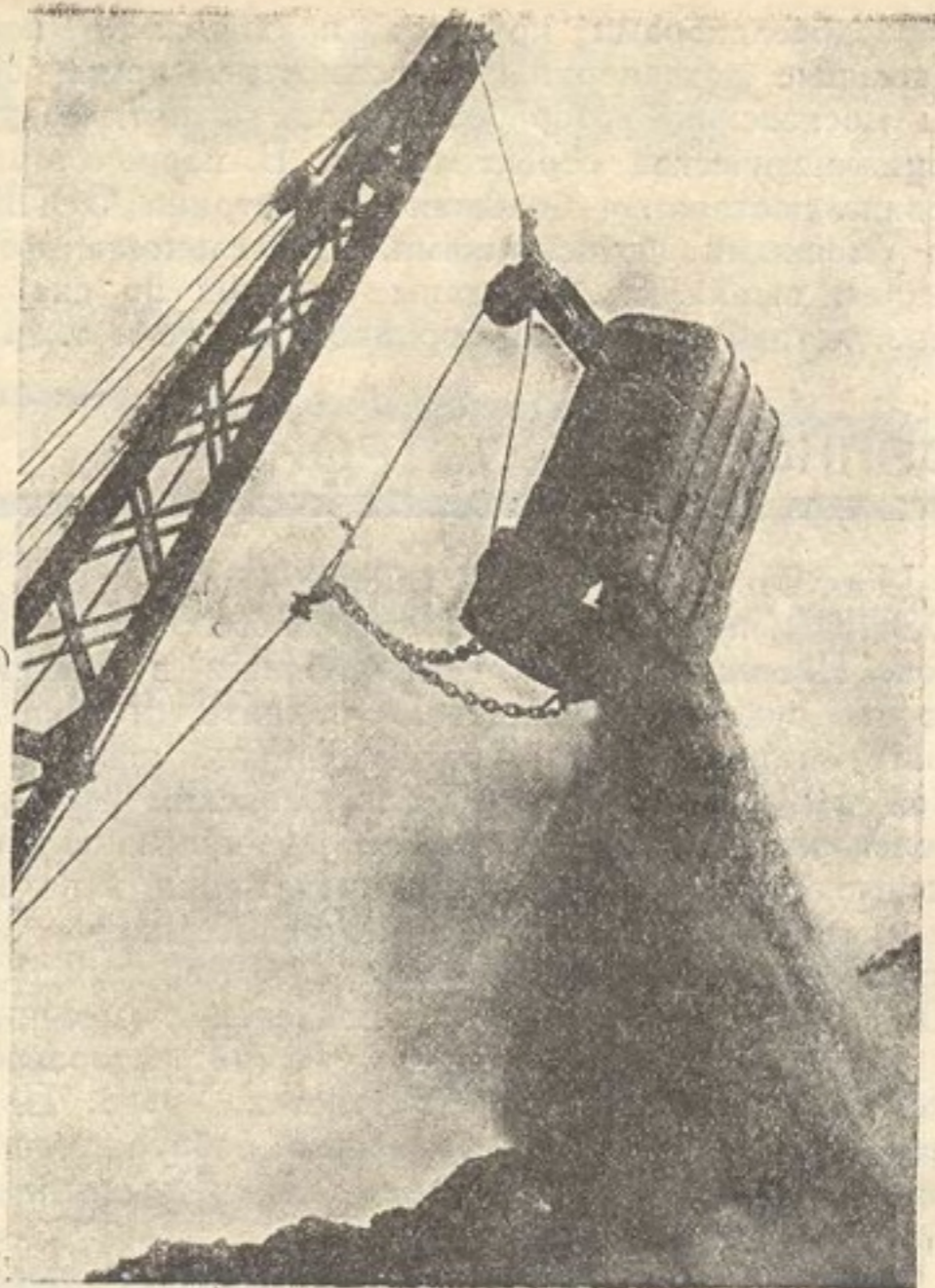
РАБОТА ЭКСКАВАТОРА „МАРИОН“ М. Пэнсон
