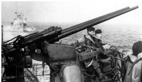
Вверху: зенитная 37-мм полуавтоматическая пушка С/30 в спаренной установке LC/30.
