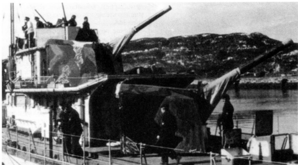
Кормовые 127-мм орудия эсминца Z-5 «Пауль Якоби», 1940 г.
