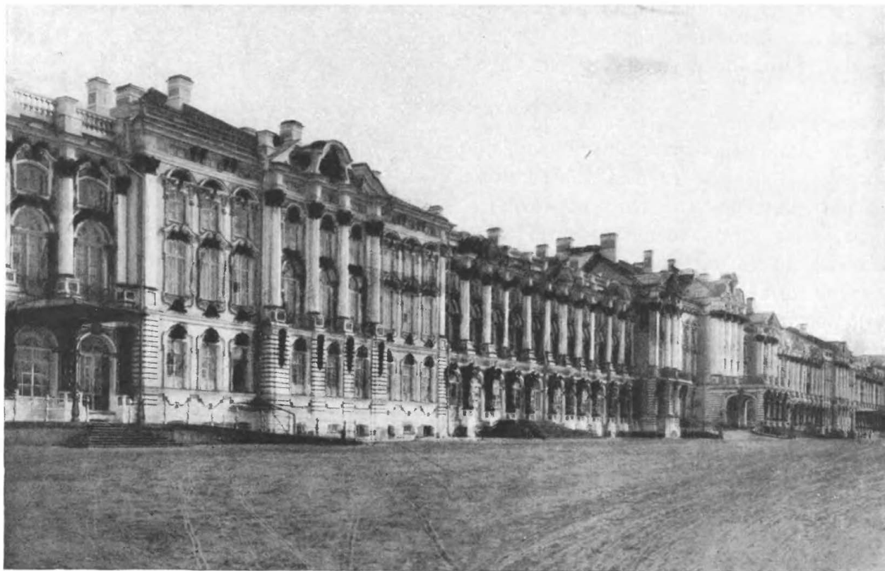
В. Растрелли. Большой (Екатерининский) дворец в Царском селе (Пушкине). Общий вид со стороны двора. 1752—1756 годы.
