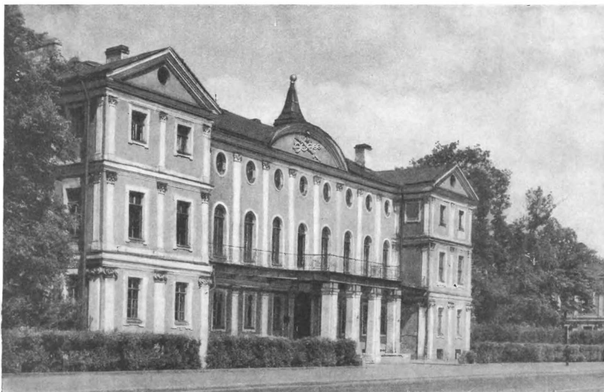
Д. Фонтана и Г. Шедель. Дворец А. Д. Меншикова на Васильевском острове в Ленинграде.
