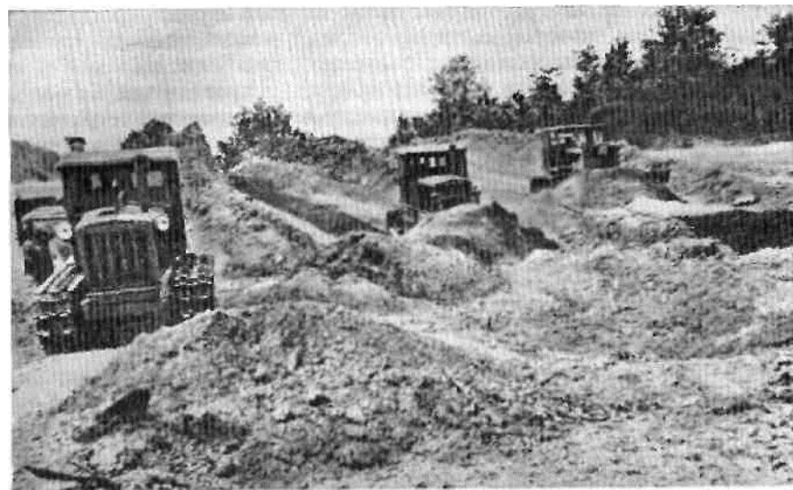
Освоение склонов методом вертикальной планировки.
