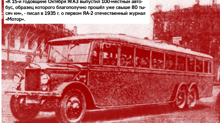
ЯА-2 отличали два запасных колеса на корме и овальное заднее окно. Ленинград, 8 ноября 1932 г.
