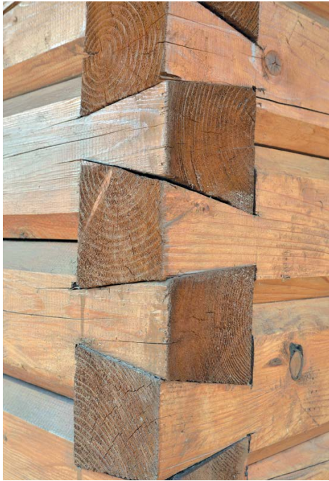
Рис. 11. Брус со снятыми фасками
