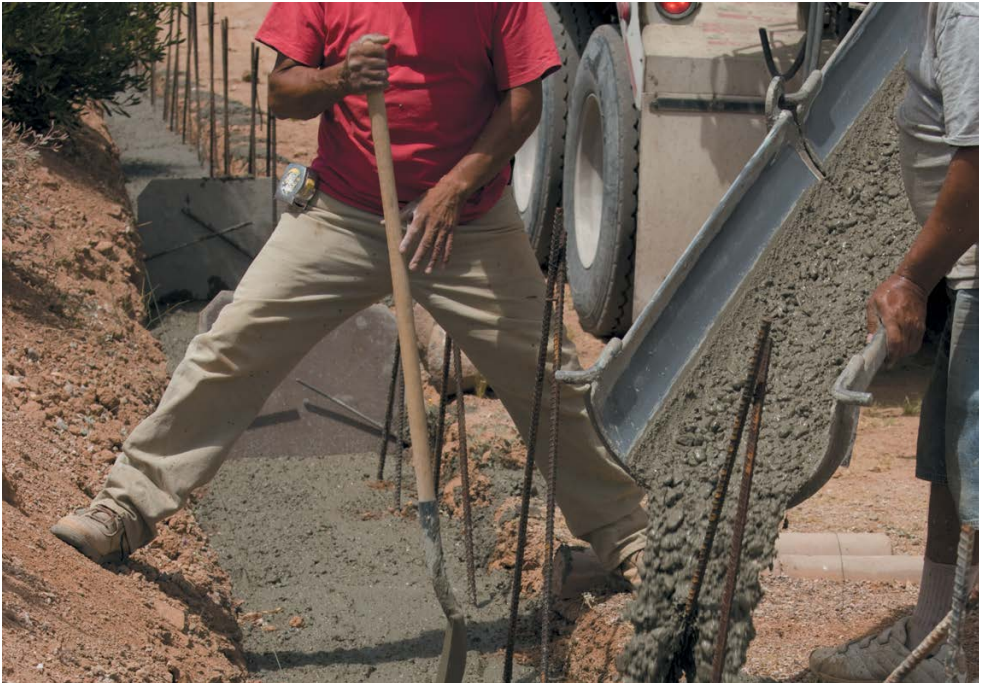
Рис. 6. Фундамент «в грунт»
