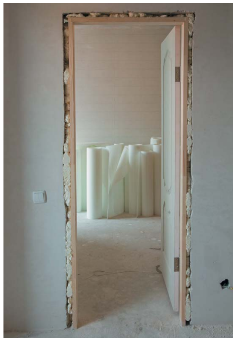
Рис. 25. Заполнение зазоров монтажной пеной
