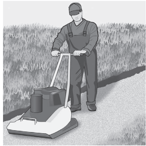
Рис. 3.8. Уплотнение песка с помощью вибротрамбовочной машины
