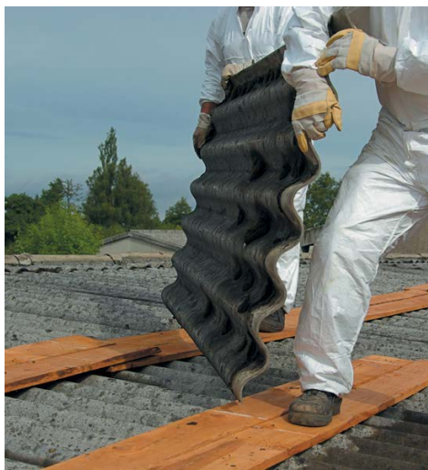
Рис. 15. Асбестоцементный лист (шифер) мало применяется в современном индивидуальном строительстве, несмотря на дешевизну: неэкологичен, недолговечен, сложен в уходе
