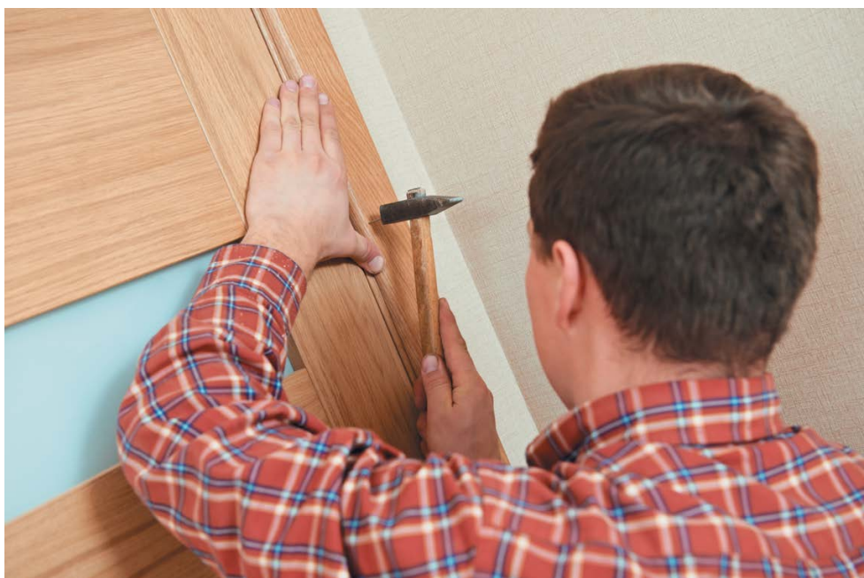
Рис. 27. Установка наличников
