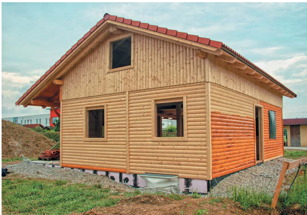
Рис. 7. «Подушка» отмостки выполнена из щебня
