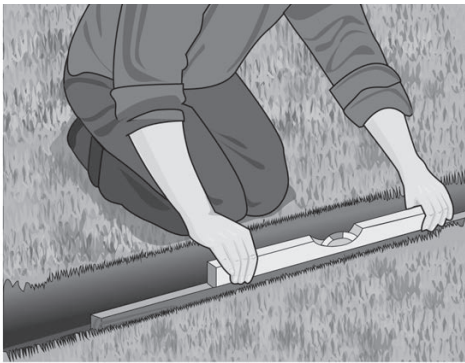
Рис. 2.5. Проверка траншеи под дренаж уровнем
