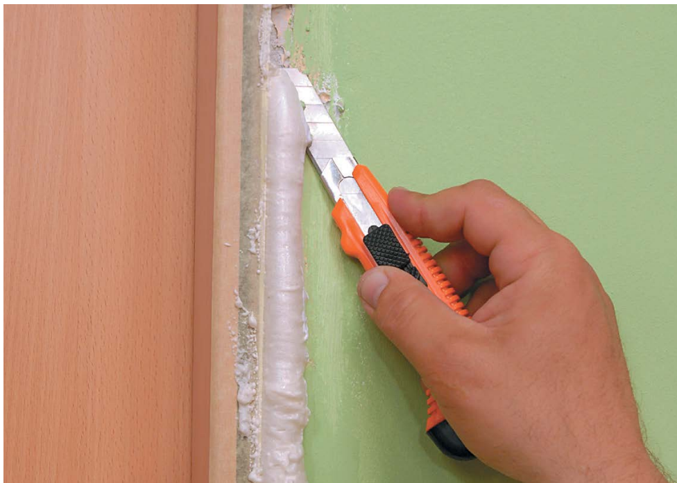
Рис. 26. Удаление излишков затвердевшей пены
