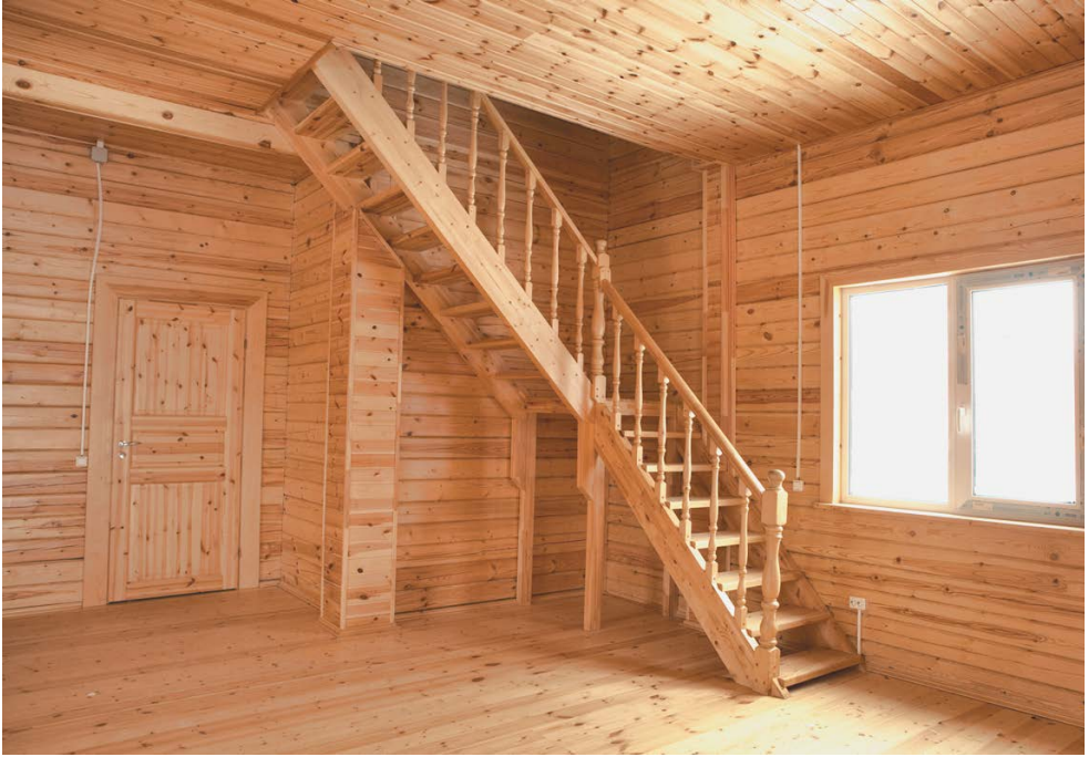
Рис. 28. Деревянная лестница в доме из бруса
