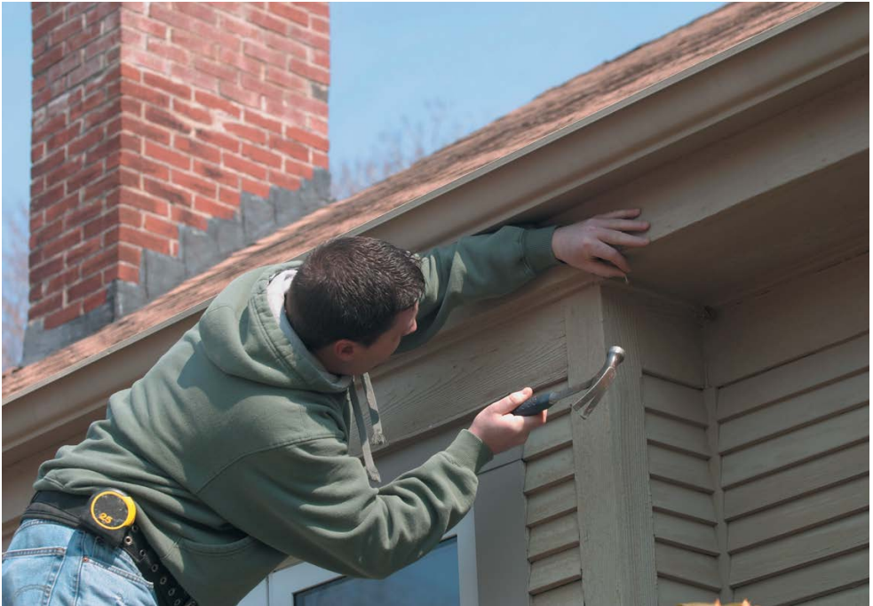
Рис. 44. Завершение монтажа сайдинга
