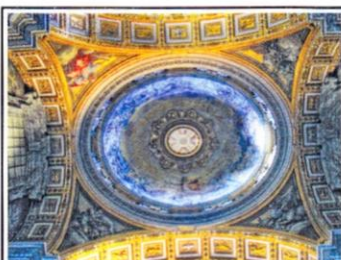
Купол собора создан по проекту великого Микеланджело. Он отказался от плана Браманте сделать купол полусферическим и взял за основу проекта более вытянутый купол Флорентийского собора, созданный Брунеллески. Микеланджело руководил постройкой в течение 18 лет. За это время успели возвести лишь барабан купола. Работы были закончены спустя четверть века после кончины мастера его учеником – Джакомо делья Порта (1540-1602). Высота купола составила 189 м, диаметр его купола – 42 м. По его барабану идет на латыни цитата из Евангелия от Матфея: «Ты – Петр, и на сем камне Я создам Церковь Мою, и дам тебе ключи Царства Небесного».
