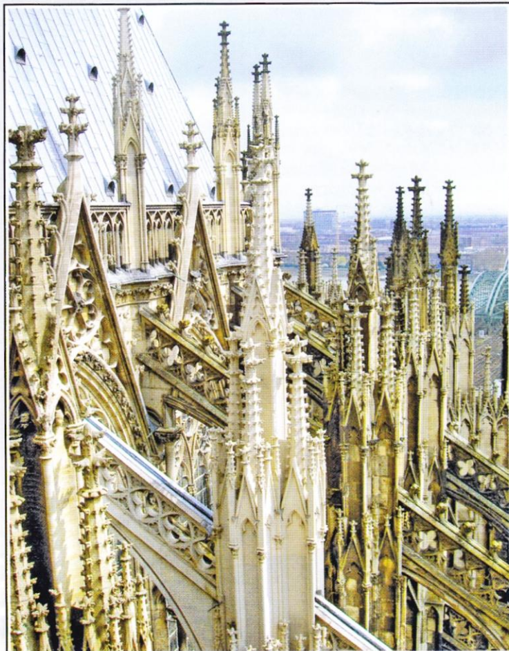
Внутренняя высота боковых нефов собора составляет 19,8 м. Общая площадь крыши – 12 тыс. м 2 . При взгляде сверху видны многочисленные вытянутые кверху башенки – пинакли. Они служат наверху для сложной системы аркбутанов и контрфорсов, напоминающих своеобразные архитектурные «ребра» собора.
