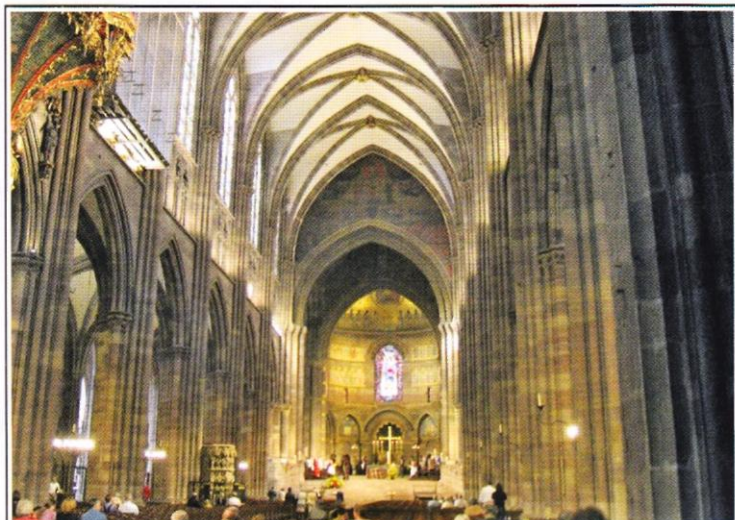
Работы над строительством главного нефа были закончены к 1275 г. Как и в случае многих других готических соборов, значительную нагрузку свода взяли на себя контрфорсы и аркбутаны; они украшены небольшими башенками – пинаклями.
