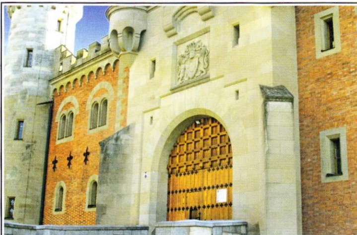
Строительство замка началось с возведения деревянных лесов. Постепенно стали вырисовываться контуры стен, местами продолжающих природные вертикали утеса. К 1873 г. были завершены ворота и фланкирующие их две круглые башни. Справа и слева проем ворот украшен небольшими башенками и узкими машикулями. Однако они – всего лишь имитация настоящих бойниц косога боя.
