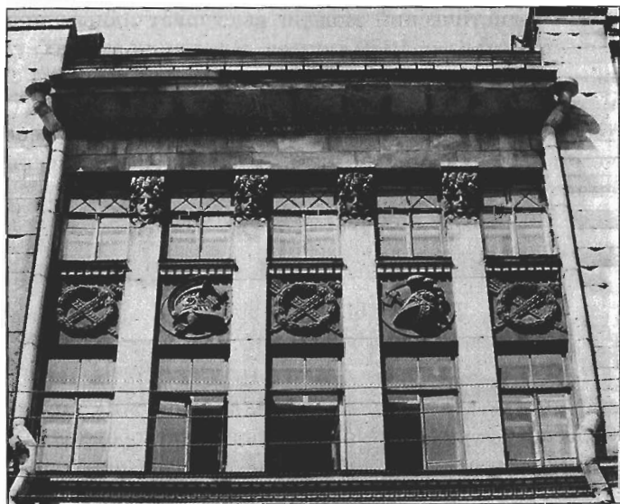
Фрагмент фасада Торгового дома
