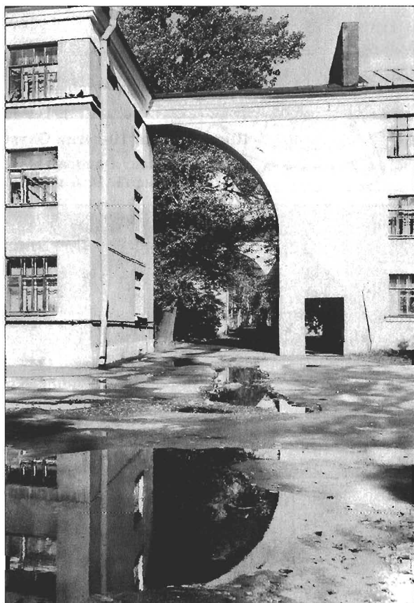
Полуарка между домами на Тракторной улице
