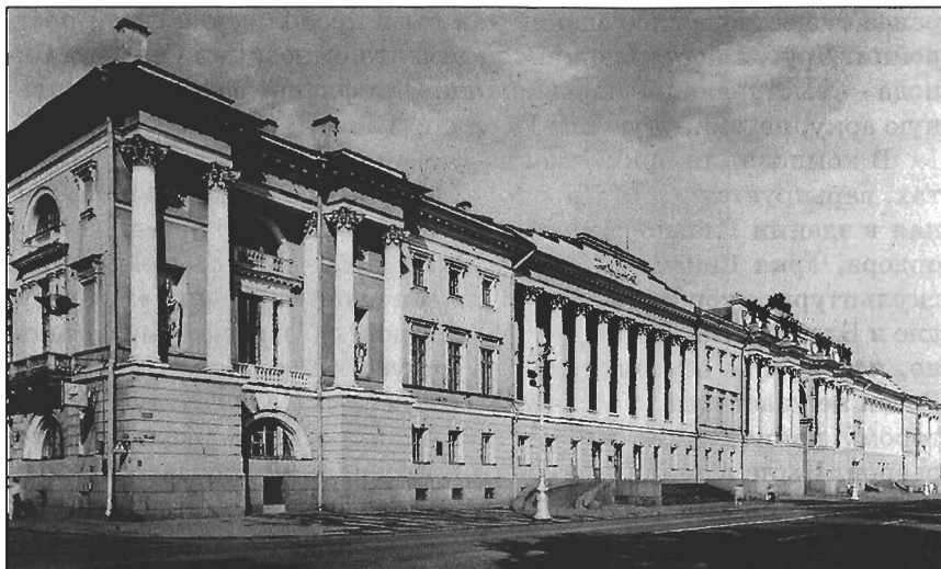
Здание Сената и Синода
