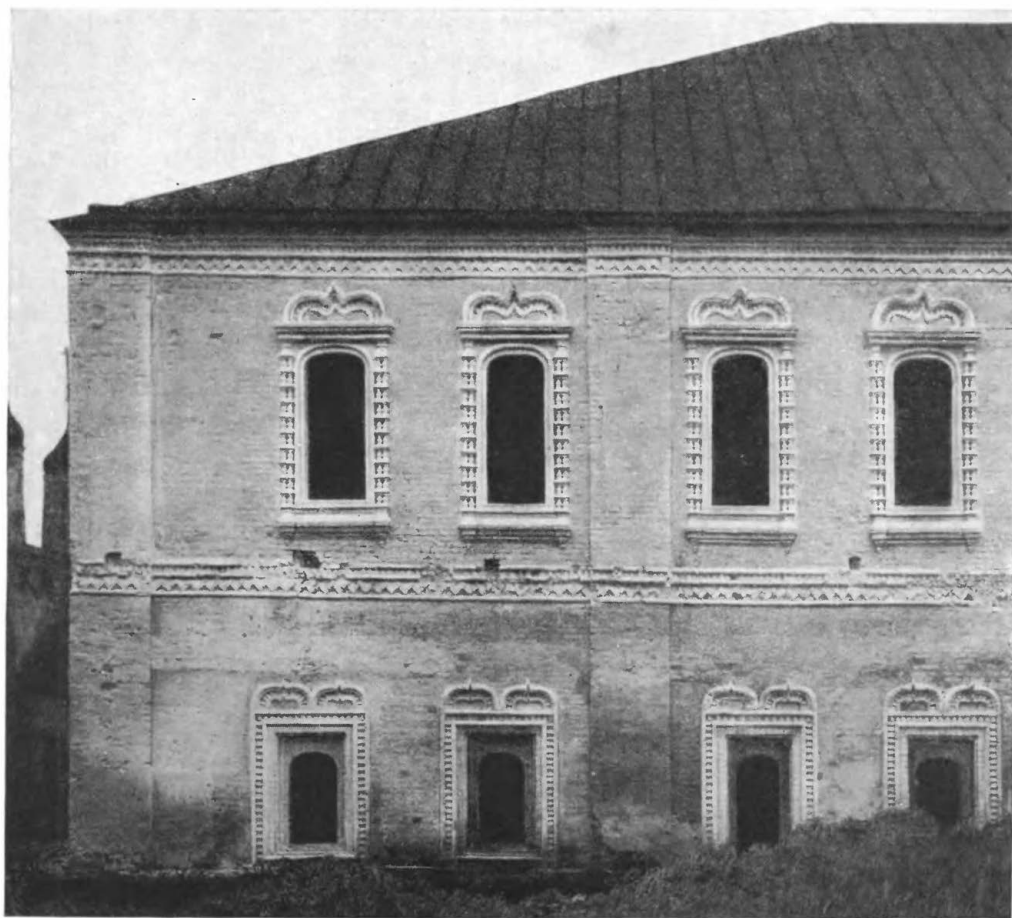
Архиерейский дом в Ярославле. 1690 год. В процессе реставрации.
