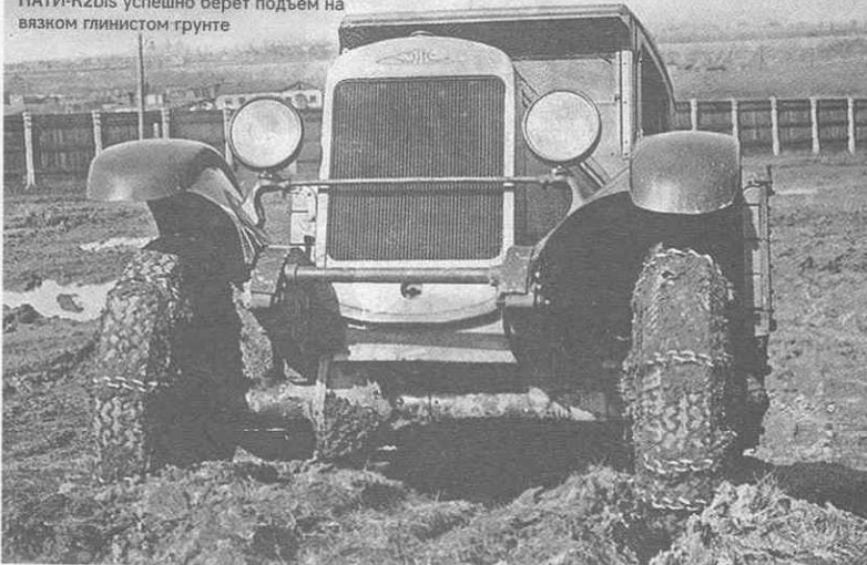
НАТИ-K2bis успешно берёт подъём на вязком глинистом грунте
