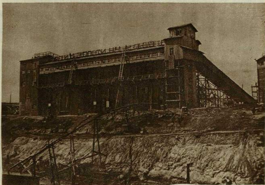
Бетонный комбинат на строительстве Волжской плотины
