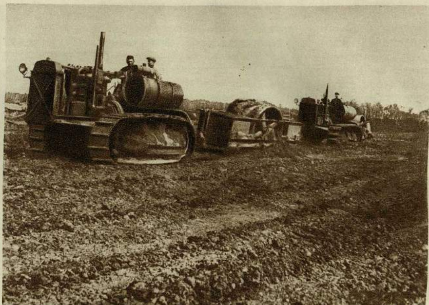
Укатка грунта на Восточной дамбе строительства канала Москва—Волга
