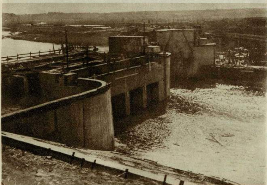
Общий вид строительства Карамышевской плотины
