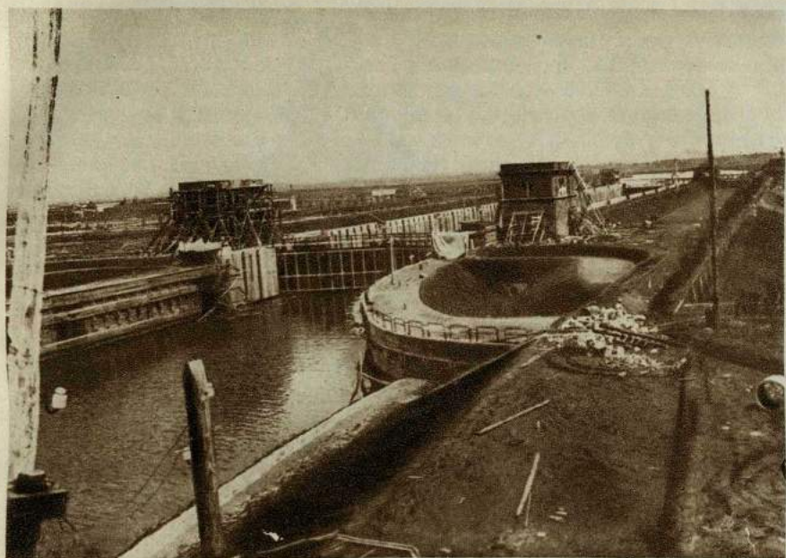
Общий вид строительства шлюза Перерва
