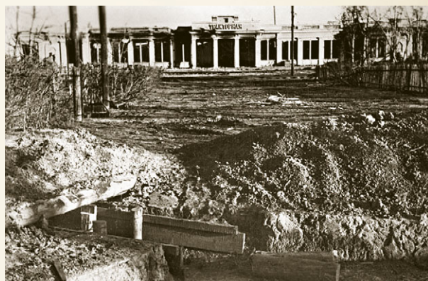
Сохранившееся до настоящего времени здание железнодорожной станции «Тракторная-Товарная». Ноябрь 1942 года
