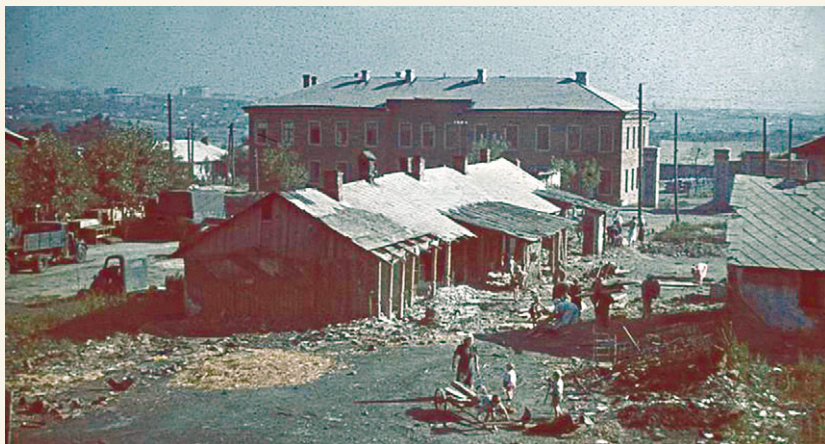
Снимок немецкого военного корреспондента — жители одного из рабочих поселков разбирают поврежденное здание. Сентябрь 1942 года
