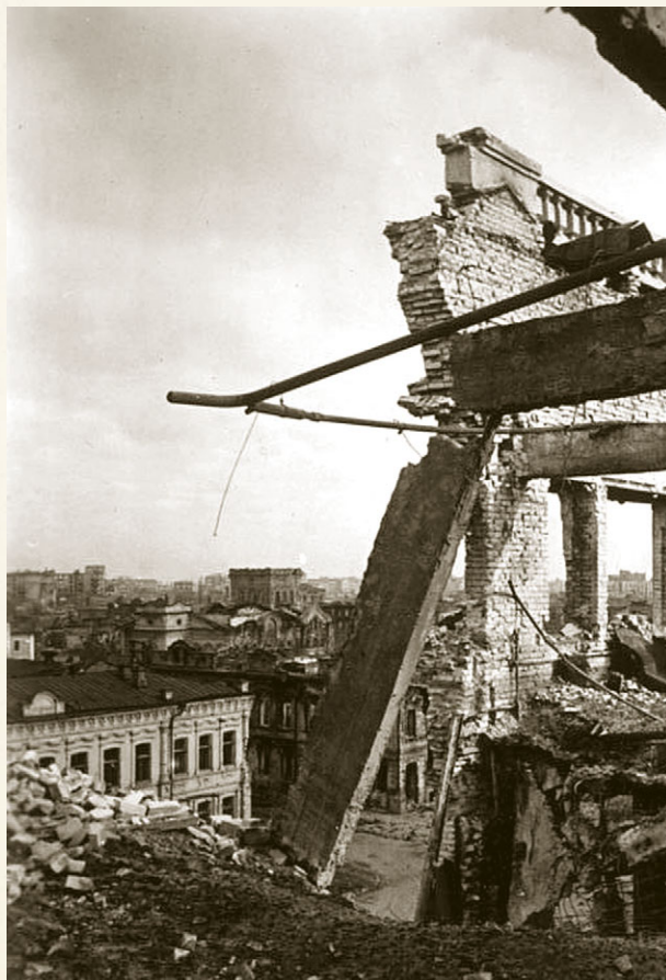
Руины одного из сталинградских зданий. Октябрь 1942 года
