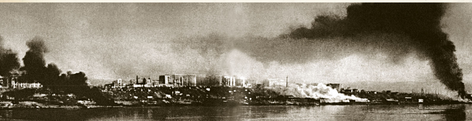
Панорама горящего центра города с Волги. Слева — здание Госбанка, в центре — комплекс зданий НКВД, справа — горящие баки Нефтьсиндиката
