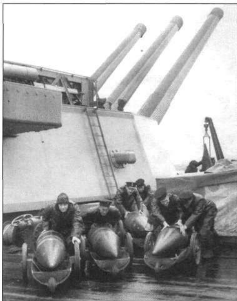
Для транспортировки снарядов главного калибра использовались специальные трехколесные тележки (слева и внизу)
