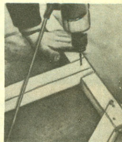
▲ Сборка каркаса стены.
