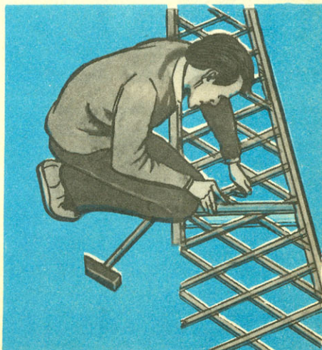
▲ Монтаж предварительно собранной деревянной решетки на каркасе панели.
