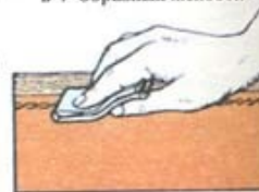
4 Прижмите обрезанную кромку в углубление
