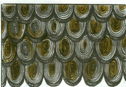
Деревянная «чешуя» получается из спилов ствола дерева (овальная форма заготовок — за счет распиливания под углом).
