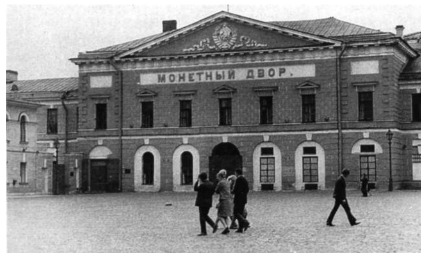
Здание Ленинградского монетного двора, построенное в 1805 году.
