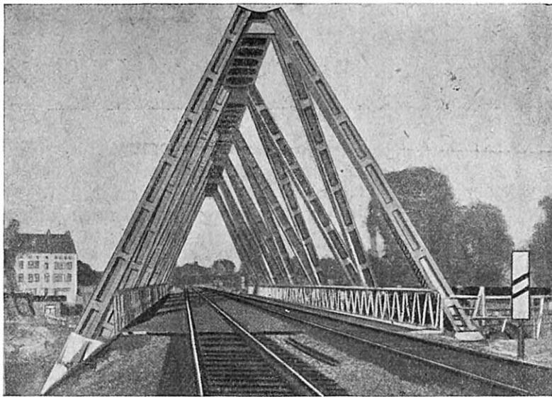
Рис. 52. Треугольный мост в Руре
