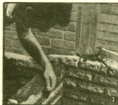
Рис. 1. Садовый очаг и некоторые этапы его изготовления: 1 — разметка, 2 — установка первого пояса кирпичей; проверка горизонтальности по уровню, 3 — расшивка швов кладки, 4 — изготовление стола.
