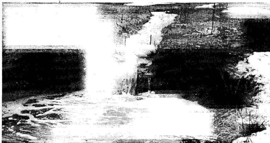
Рис. 20. Безопасный для роста вершины оврага пропуск потока талой воды через эластичный водосброс из армированной полиэтиленовой пленки
