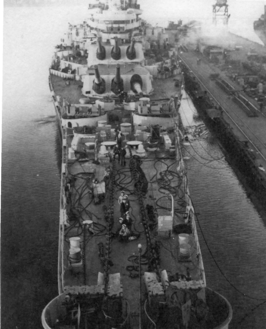
Необычную форму носовой части корпуса последних американских линкоров наглядно демонстрирует этот снимок «Нью-Джерси», сделанный на верфи «Пьюджет Саунд» в июне 1945 г.
