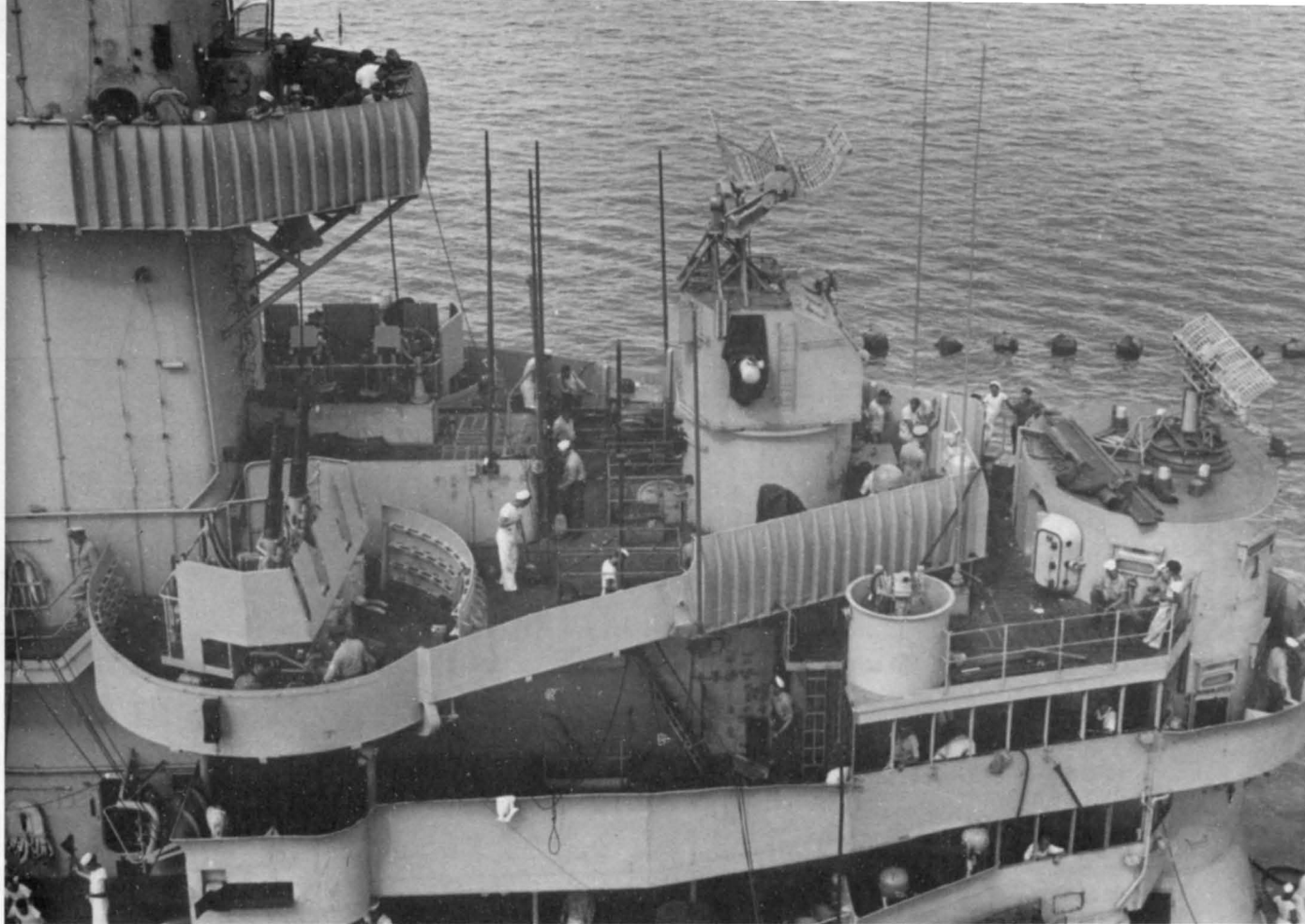
Вверху: фрагмент носовой надстройки «Айовы», ноябрь 1943 г. На крыше боевой рубки видна антенна радара Mk-3; ярусом выше находится КДП Mk-37 с РЛС Mk-4. На переднем плане в кольцевом ограждении находится директор-колонка Mk-51 для управления огнем 40-мм автоматов «Бюфорс». Слева: 40-мм и 20-мм автоматы на надстройках «Айовы», июль 1943 г.
