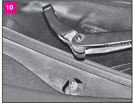
10 Снимаем рычаг очистителя ветрового стекла. Меняем его на аналогичный новый и собираем в обратной последовательности
