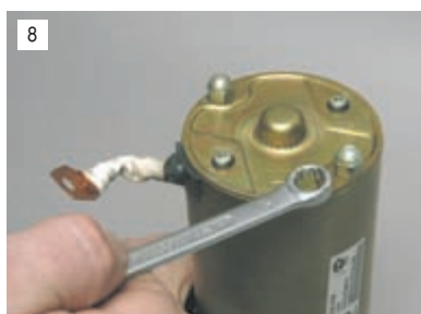
8 Ключом «на 10» отворачиваем две гайки стяжных шпилек.
