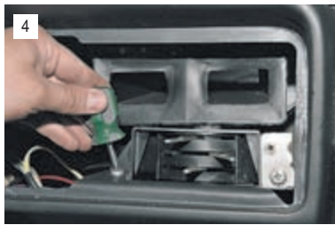
4 Той же отверткой отворачиваем два винта крепления к панели приборов блока управления отопителем.
