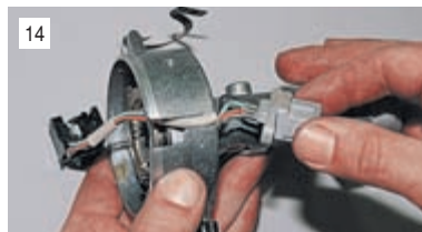
...и снимаем датчик. Неисправности датчика чаще связаны с механическими повреждениями проводов.
