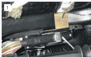
Поддев отверткой запорную скобу колодки жгута проводов...
