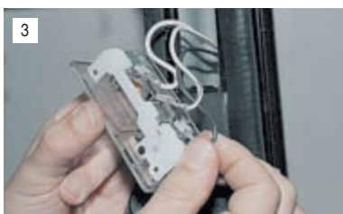
Отсоединяем провода от неисправного плафона и подсоединяем их к новому.
