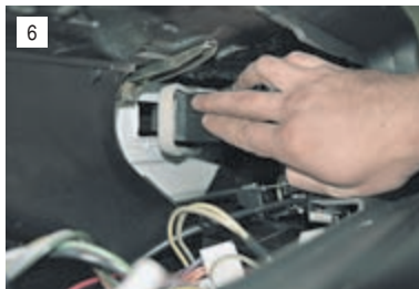
6 Надавлив сбоку на центральный воздухопровод, рукой вынимаем его из окна моторного щита.
