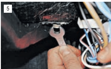
5 Ключом «на 10» отворачиваем по одной гайке крепления боковых воздухопроводов к кузову.
