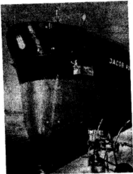
Рис. 11.12. Цилиндрический фартук с бульбом
