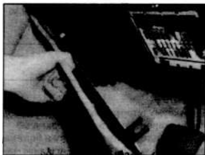
5.1a Установленная под приборной панелью коробка плавких предохранителей/реле
