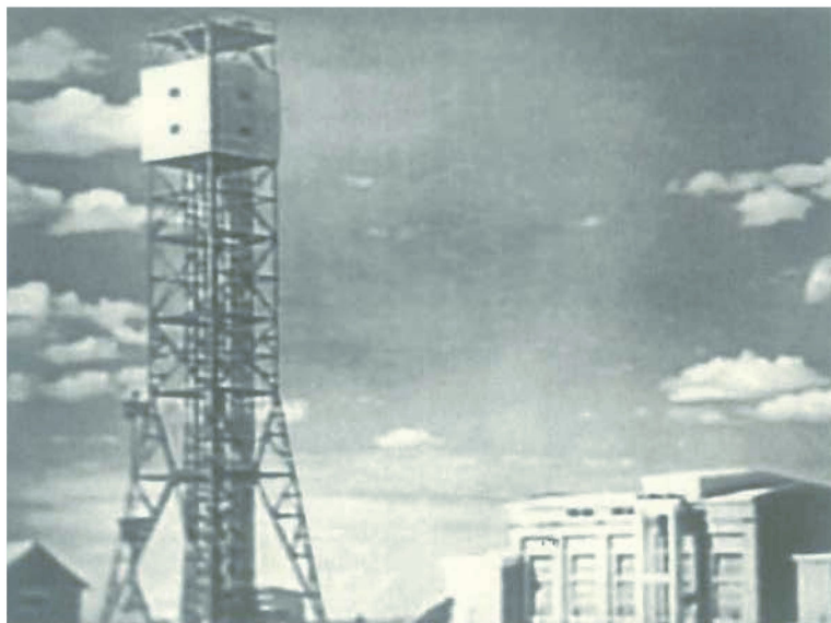
Башня на Семипалатинском полигоне для испытания РДС-1
