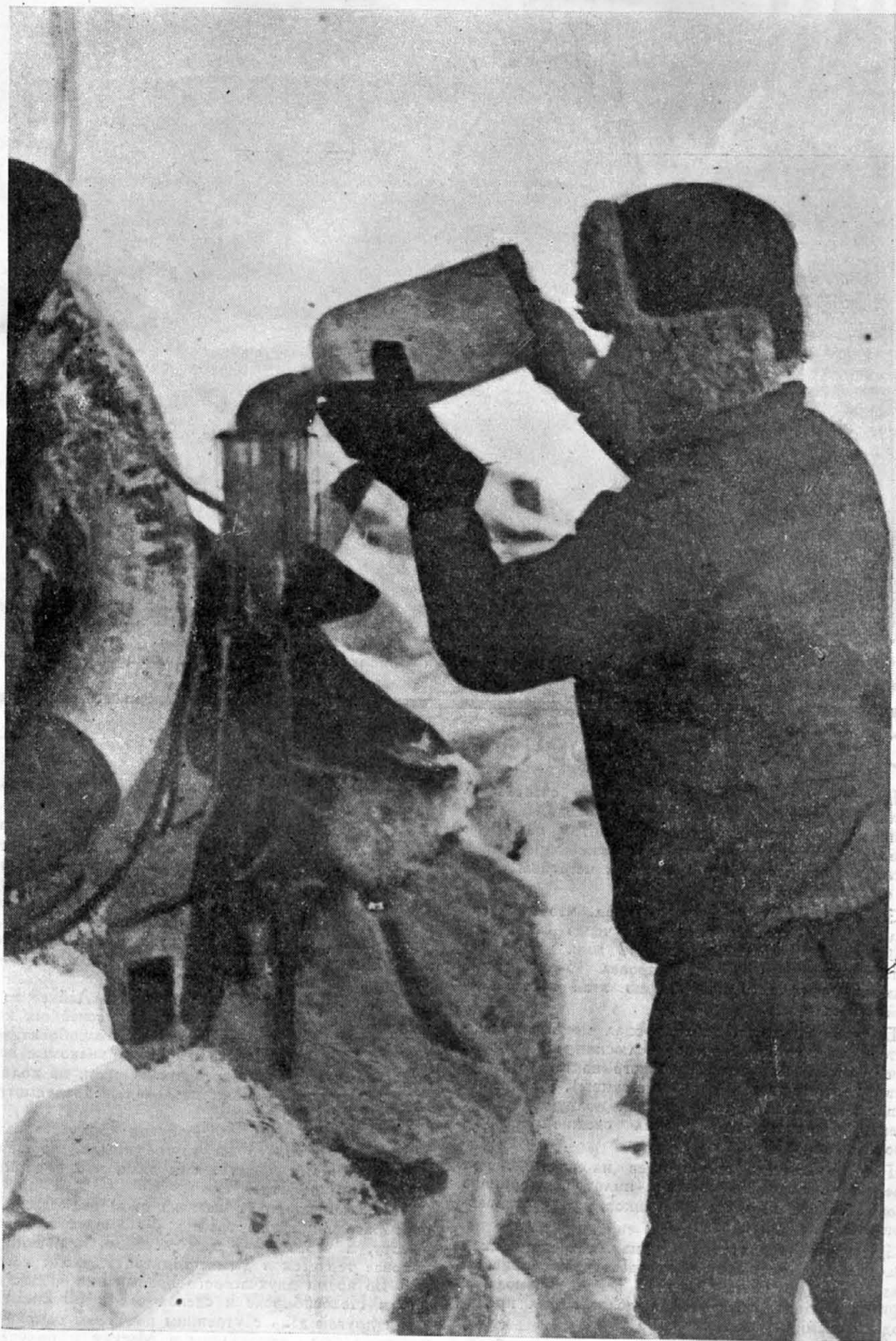
П. Новицкий. — Приспособление для «центрального отопления» одной из палаток. Кирпичи нагревались посредством нефти
