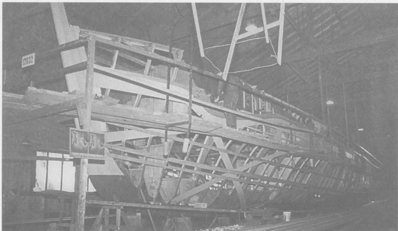
Корпус «шнельбота» на стапеле верфи «Люрсен».
