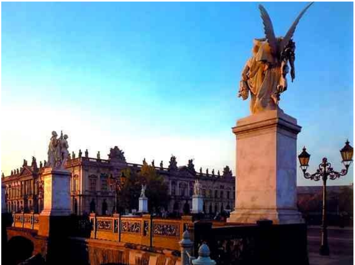
Берлин. Замковый мост и Арсенал на Унтер-ден-Линден
