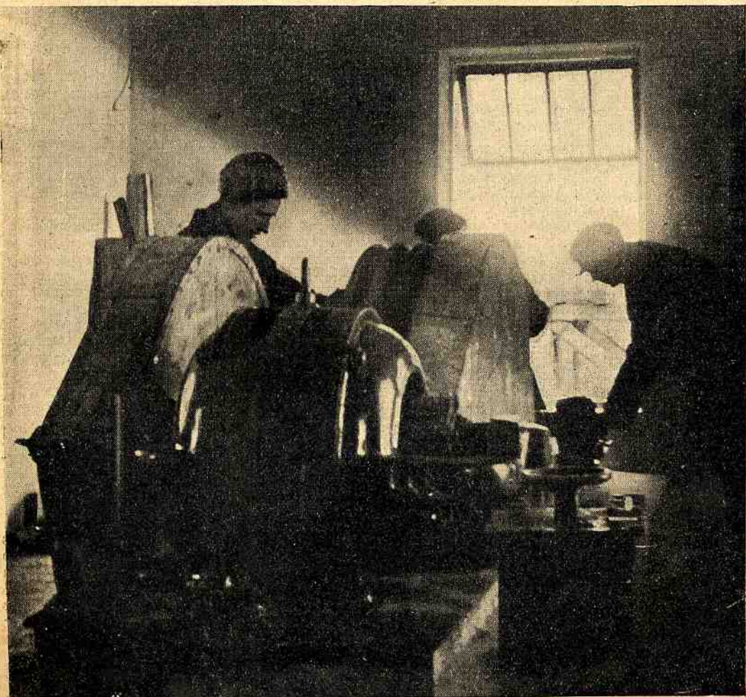
УСТАНОВКА НОВОЙ ТЯГАЛЬНОЙ МАШИНЫ В ШАХТЕ Л. Горбатенко (Донбасс, «Боковский Антрацит», шахта № 22)
