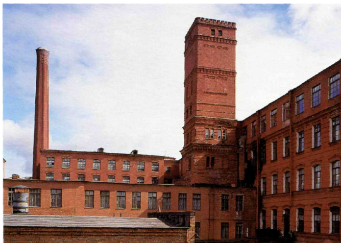
• Главный прядильный корпус
