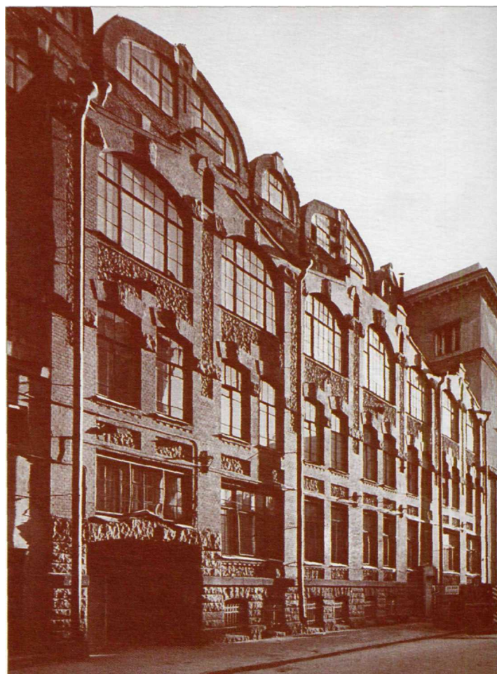
Главный корпус по улице Яблочкова
