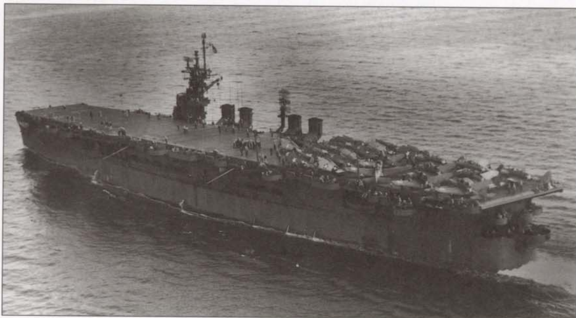
Вверху. Легкий авианосец типа «Индепенденс». Кормовая часть полетной палубы заполнена самолетами. Обратите внимание на четыре дымовые трубы и небольшую надстройку.
