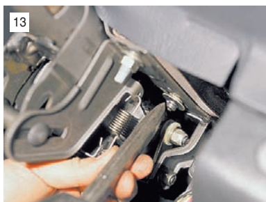
13 Два болта переднего крепления кронштейна вала рулевого управления имеют срезные головки, поэтому отворачиваем их, нанося удары зубилом в тангенциальном направлении.
