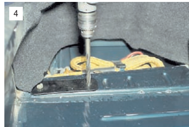
...и еще два – из багажника, используя усиливающую накладку как кондуктор, чем исключаем несовпадение отверстий из-за увода сверла.
