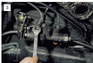
Ключом "на 10" отворачиваем четыре штуцера тормозных трубок и выводим трубки из корпуса регулятора.
