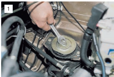
1 Ключом на «15» отворачиваем гайку левой опоры силового агрегата.
