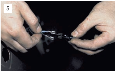
5 При замене патрона отсоединяем от него провода.
