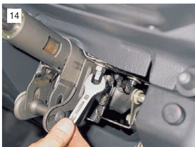
14 Ключом "на 13" отворачиваем две гайки заднего крепления...
