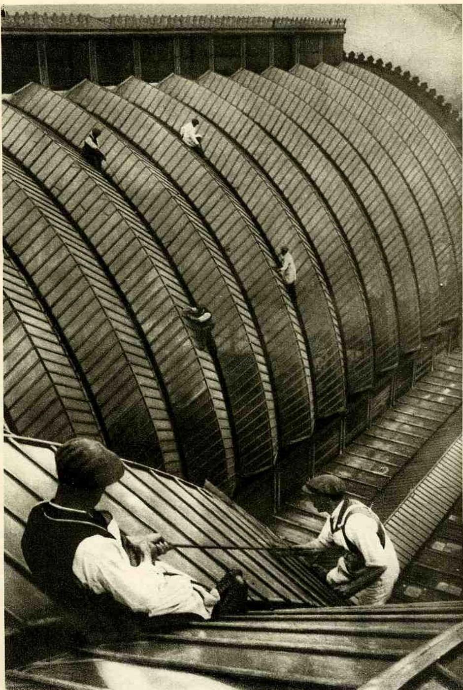
РЕМОНТ КРЫШИ БЕРЛИНСКОГО ВОКЗАЛА
