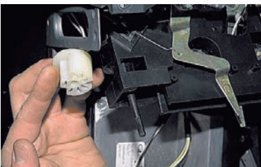
...отсоединяем от выключателя колодку жгута проводов,
