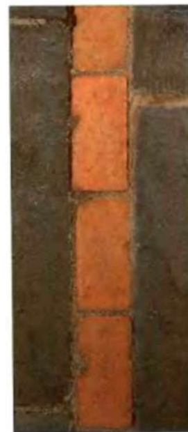
Кирпичные вставки дополняют элементы укладки
